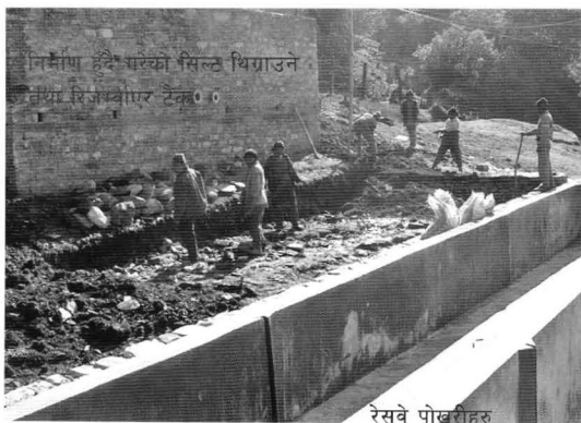
चित्र ४. रेखात्मक ले-आउटमा निर्माण गरिएका रेसवे
