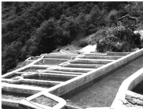
चित्र १. ट्राउट पालनको लागि सिमेण्टको प्रयोगबाट तयार गरिएको पक्की रेसवे पोखरी
